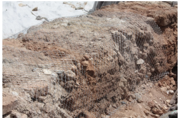
Res. 40-45: Hitit bir kerpiç-taş duvarın güçlendirilmesi
