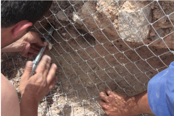
Res. 40-45: Hitit bir kerpiç-taş duvarın güçlendirilmesi
