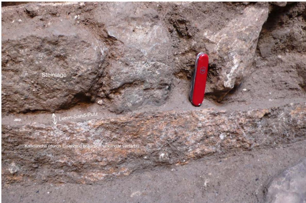
**Abbildung 5: Als gekalkter Lehmputz auf dem Bruchsteinmauerwerk interpretierte Schicht im Bereich der derzeitigen Brunnensohle**
